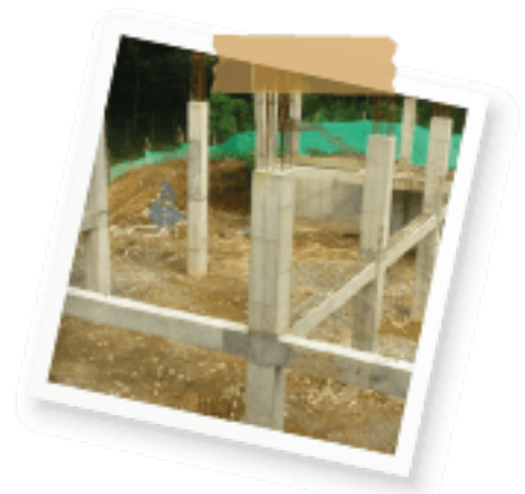
Ilustración 5: Desde la mitad del 2023 se trabaja en el último de tres edificios nuevos, donde se va a acomodar talleres para ejercicios prácticos.
