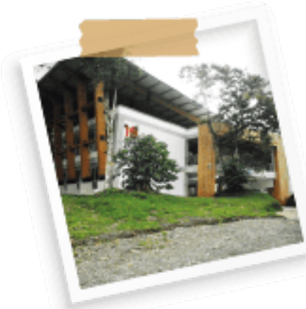
Ilustración 3: Laboratorios, aulas y oficinas administrativas se construyeron en madera laminada
